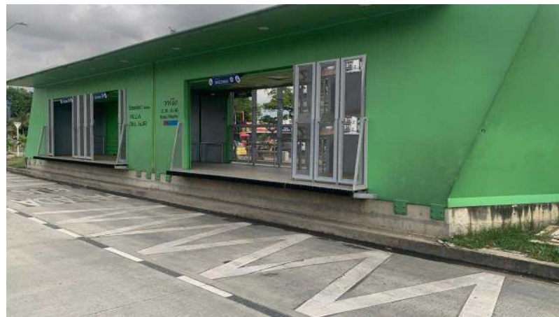
Imagen 28. Imagen ilustrativa barandas de malla expandida de techo a piso. Costado zona de abordaje.
